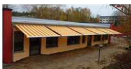
Verschattung am Verwaltungsgebäude mit Raffstores, geöffnet - Zum Vergrößern bitte auf das Bild klicken
