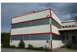
Verschattung am Verwaltungsgebäude mit Raffstores, geschlossen - Zum Vergrößern bitte auf das Bild klicken
