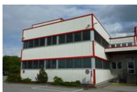
Verschattung am Verwaltungsgebäude mit Raffstores, geöffnet - Zum Vergrößern bitte auf das Bild klicken
